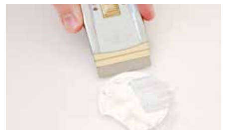
Klebereste entfernen
